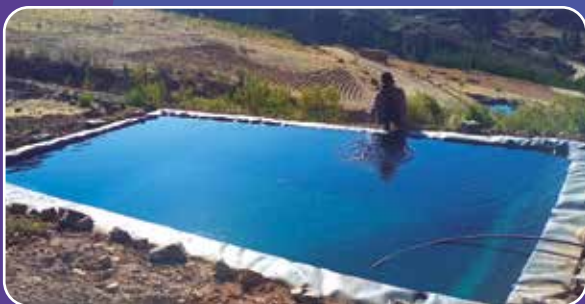
Reservorio revestido con geomembrana implementado en la comunidad Mogo Wasi
