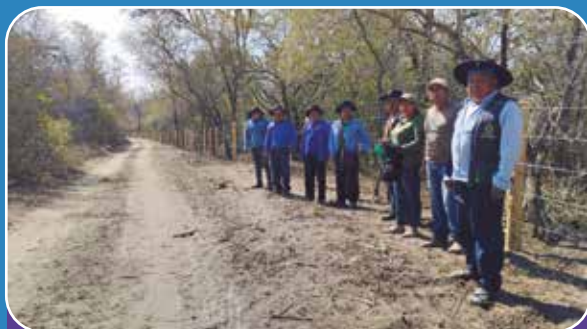
Construcción de alambrado (Comunidad Los Sotos-V.V.Guzman)
