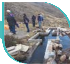
Construcción de cámaras desarenadoras del sistema de aducción Locosta
