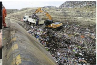
Relleno sanitario de Villa Ingenio
